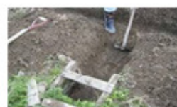
排水溝と額縁排水溝、排水口への連結
