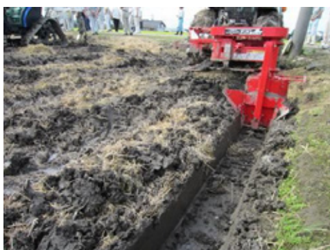
額縁排水溝の設置
