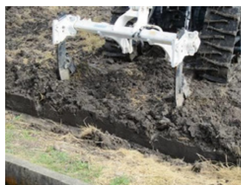
弾丸暗渠の設置
