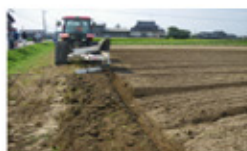
排水溝と額縁排水溝、排水口への連結
